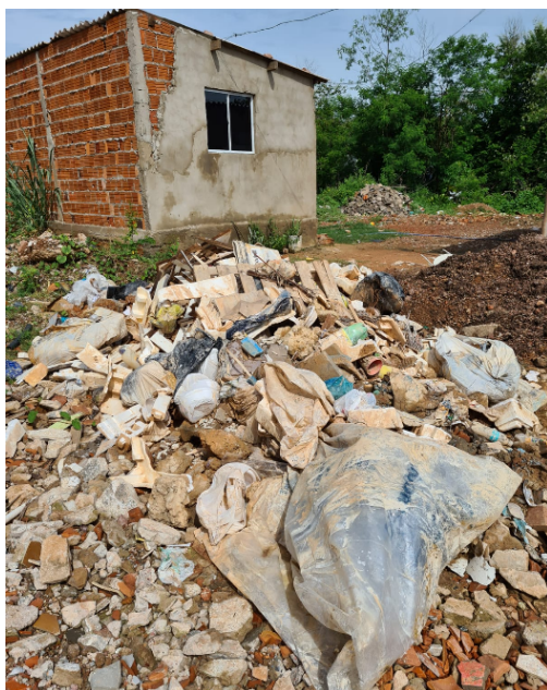
Figura 75 - Residências em APP da lagoa
