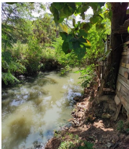
Figura 18 - Degradação das margens do córrego
