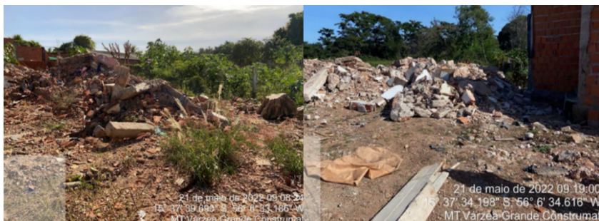
Figura 35 - Deposição inadequada dos RCC na microbacia do córrego da Manga
